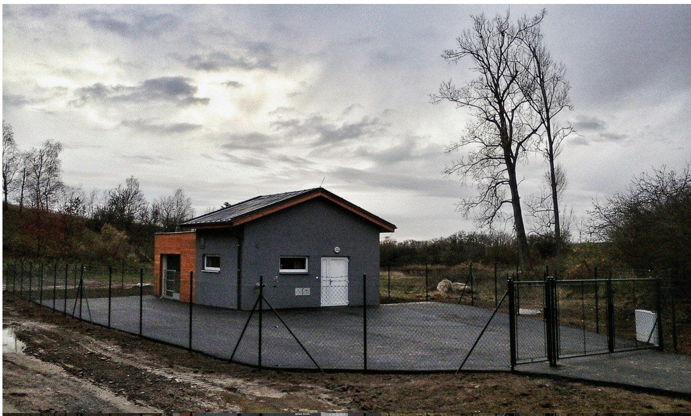
čistička odpadních vod
